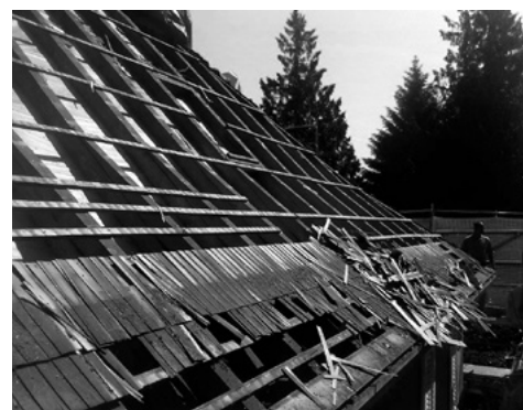
Dachsanierung des Pfarrhauses an der Kirchstr. 46
