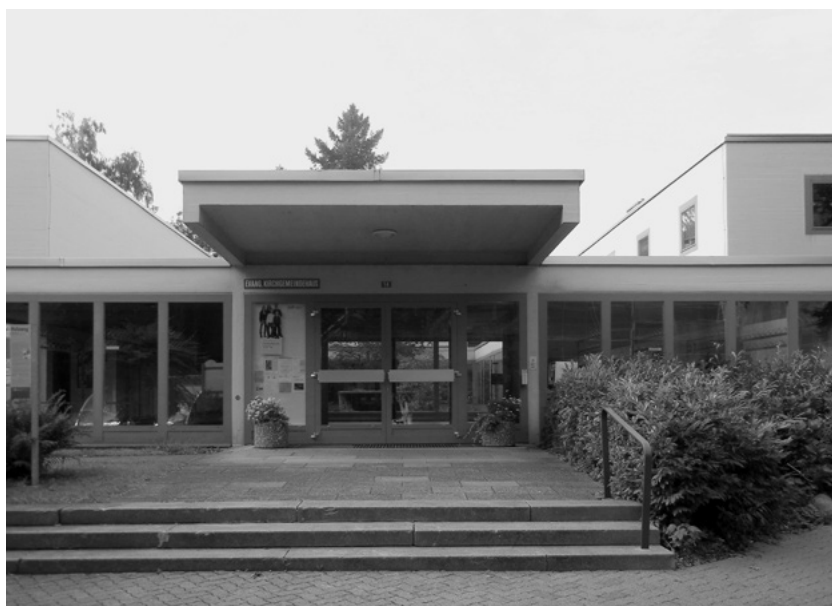
Ist-Zustand: Evang.-ref. Kirchgemeindehaus Rapperswil
